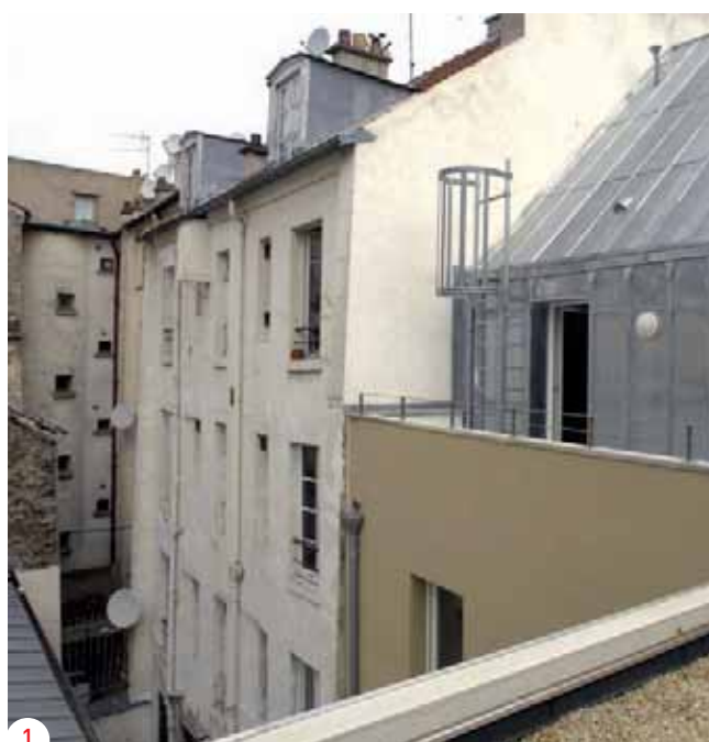
1, 2 et 3. Immeubles insalubres réhabilités par la SIEMP pour la Mairie (19 e ).
